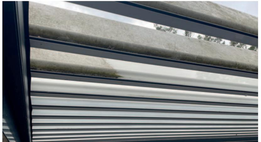
3. Pusten Sie die Lamellenführung mit einem Kompressor aus.
